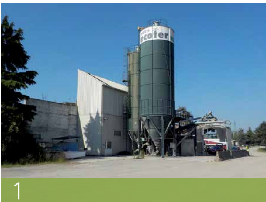
1. L'IMPIANTO DI ARLUNO THE ARLUNO BATCHING PLANT
