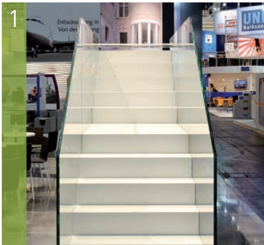
1. LA PRIMA SCALA AL MONDO IN CALCESTRUZZO AD ALTA PRESTAZIONE CON NANODUR® THE FIRST UHPC STAIRCASE IN THE WORLD MADE WITH NANODUR®
