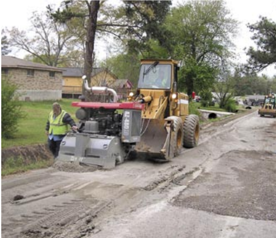
Recupero integrale – “taglia asfalto” in azione; il cemento viene mescolato al materiale della vecchia strada, per creare una nuova massicciata, solida e omogenea Full Depth Reclamation - “asphalt zipper” in action, mixing the cement into the old road to make a new, consistent and strong road base
